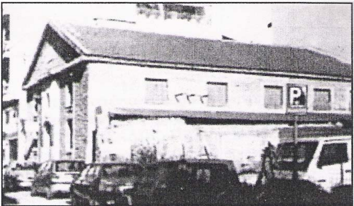
Εικόνα 23: Η καπναποθήκη Γκιζίκη στη συνοικία της Μεταμορφώσεως (Σωκράτους με Σόλωνος) στην οποία διέμεναν οι «εκ Νικομηδείας» πρόσφυγες.(φωτ.2002), Κωνσταντάρας-Σταθαράς, ό.π.,σ.23.
